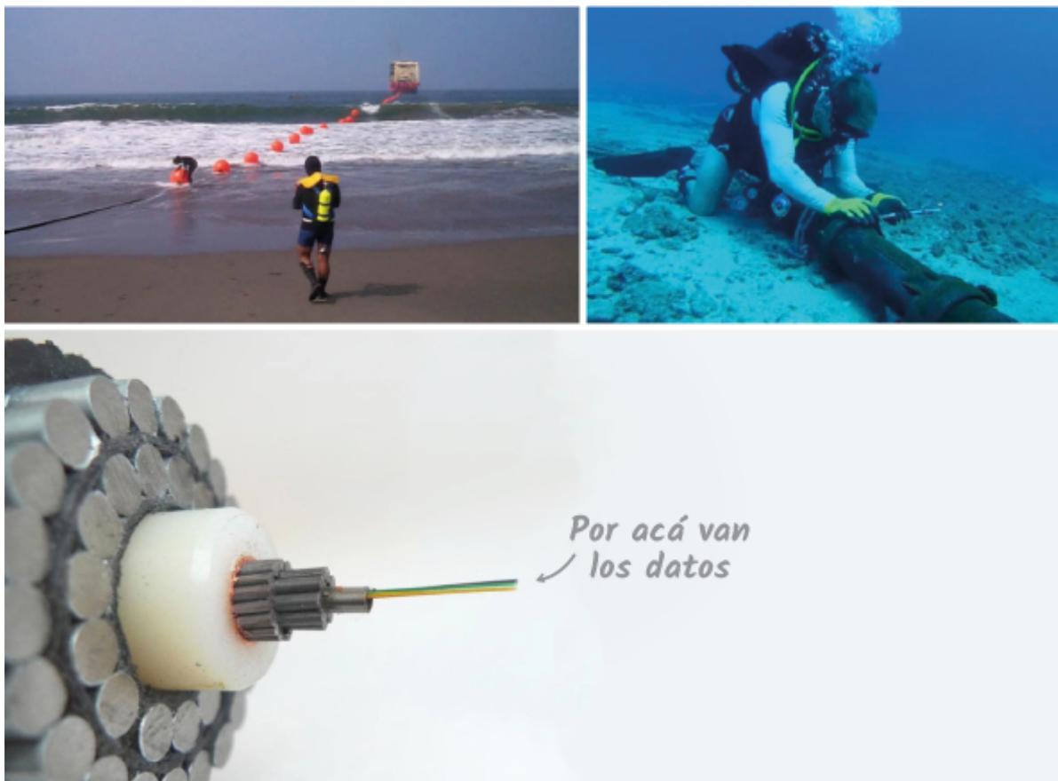
Imagen 15.1. (a) Barco partiendo de la costa para colocar el cable submarino. (b) Buzo reparando un cable submarino averiado. (c) Cable submarino de fibra óptica por dentro.<sup>20</sup>
